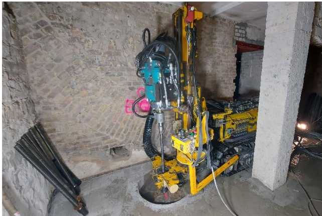
(1) Bei den Ankerbohrarbeiten kam eine KLEMM KR 701 zum Einsatz.
